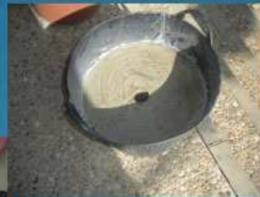
BASE DE HORMIGÓN
