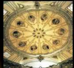
Bóveda, planta y ventanas de la Iglesia San Juan de Dios.
